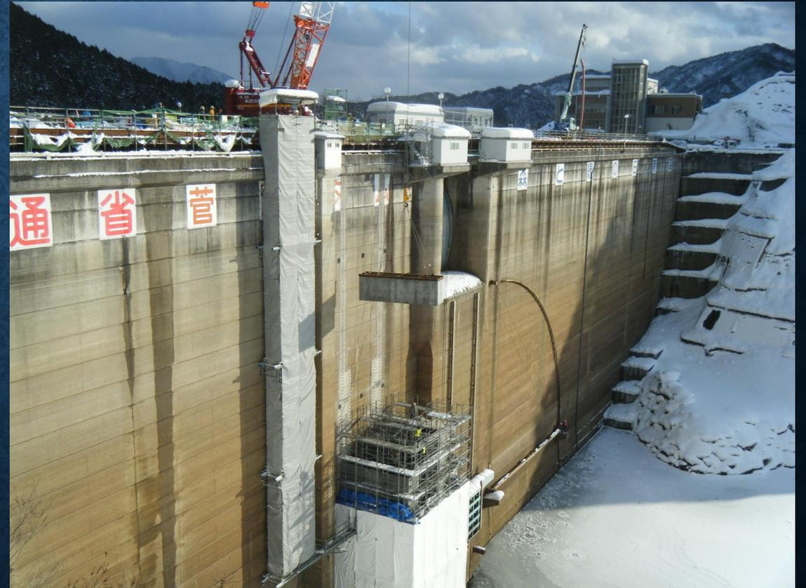
① ダム選択取水設備の付替え工事の躯体埋設型枠として
