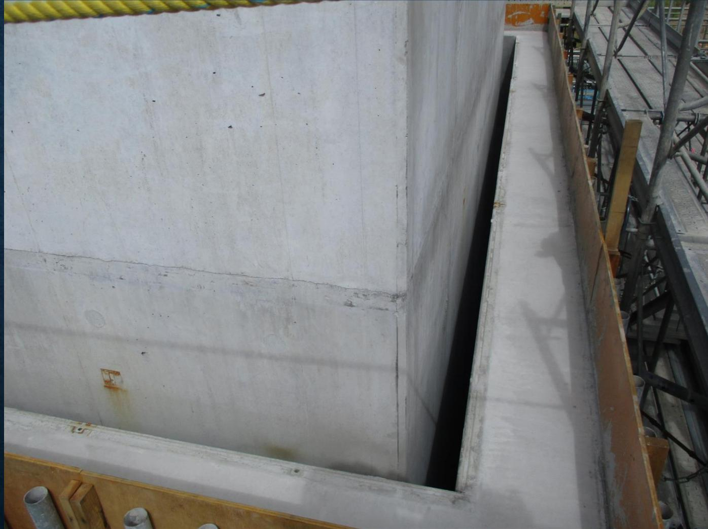
⑧ RC橋脚への埋設型枠として
