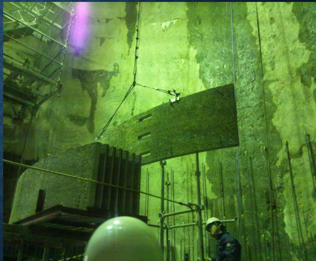
⑤ 立坑本体壁構築時の埋設型枠として
