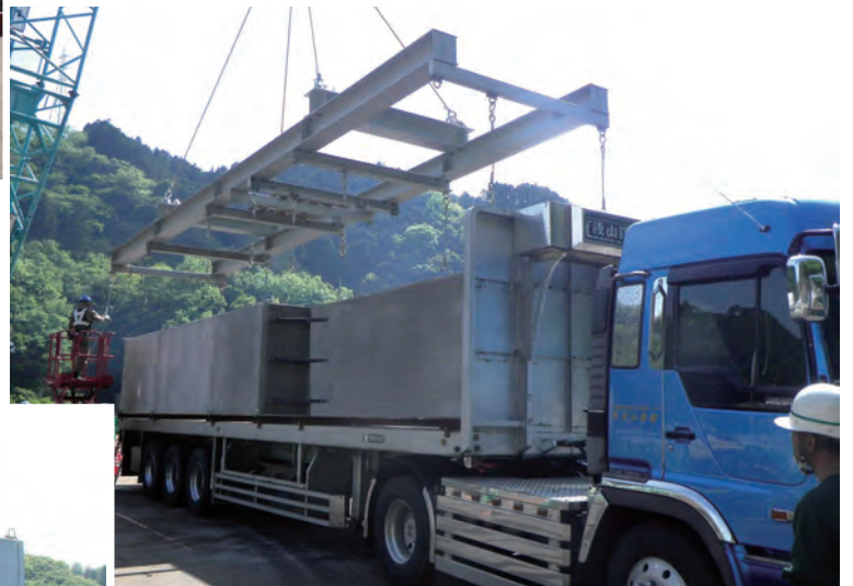
函体現場搬入状況
