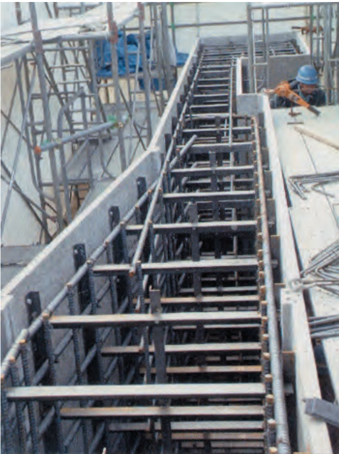
函体内配筋状況
