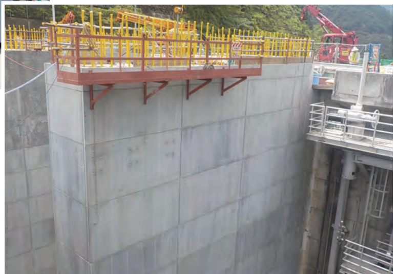
函体設置完了
