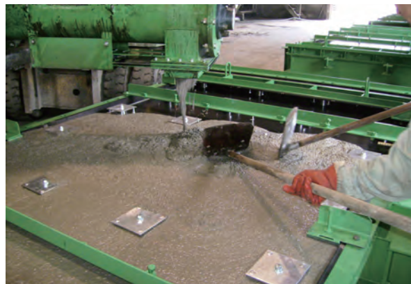
コンクリートの打設
