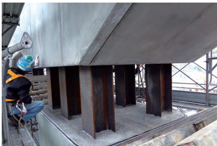
梁函体設置状況
