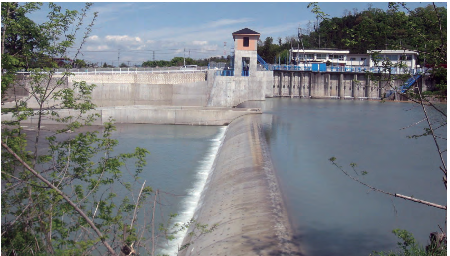
工事完了後全景
