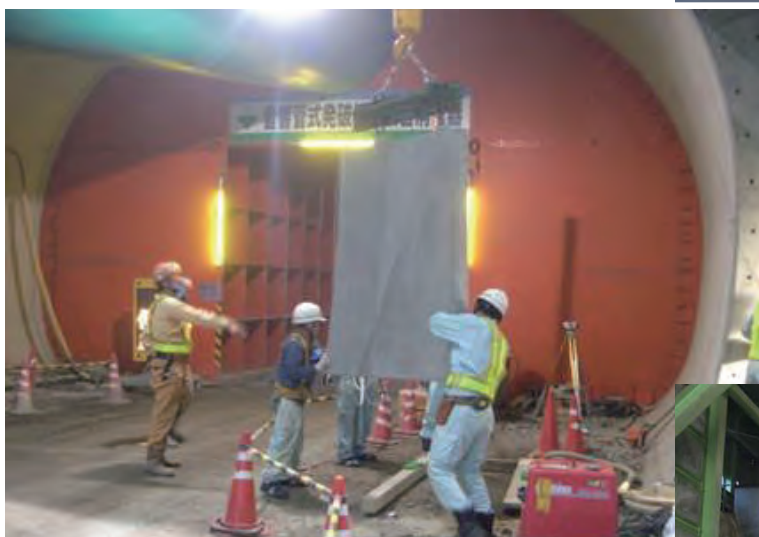
現場での建込状況
