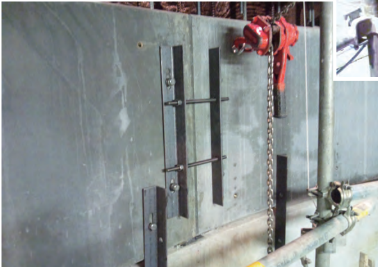
鉛直目地の仮締め状況
