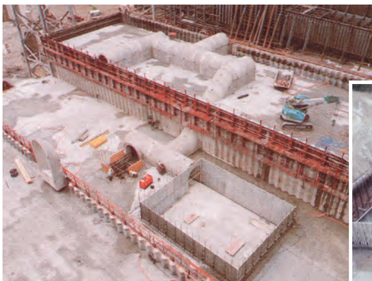
ダム堤体内構造物
