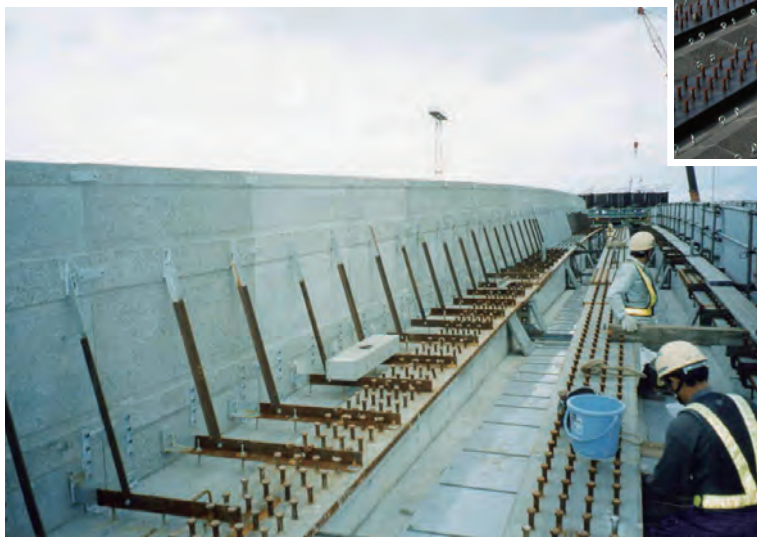
高欄型枠内面固定状況
