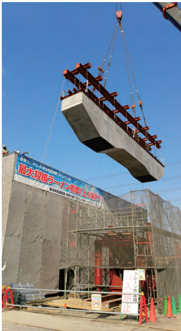
梁函体建込状況
