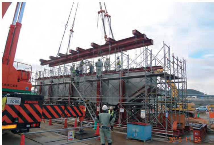
組立架台からの吊上げ状況
