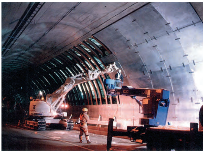
トンネル接合部覆工施工事例
