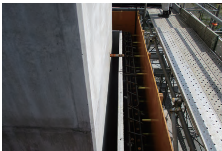
外型枠コンパネ、鉄筋、セパレーターの設置状況
