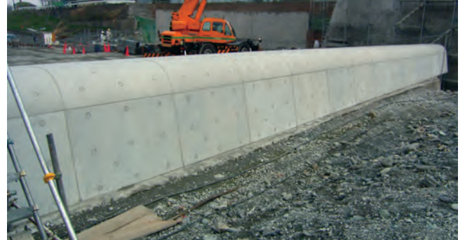
上流側設置状況
