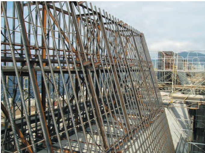
嵩上げ部の鉄筋配置（陸側）
