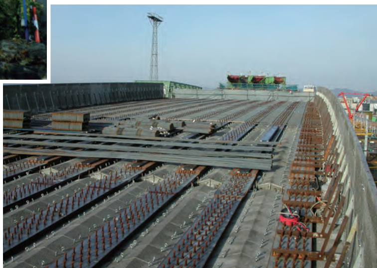
合成主桁間底版型枠設置状況
