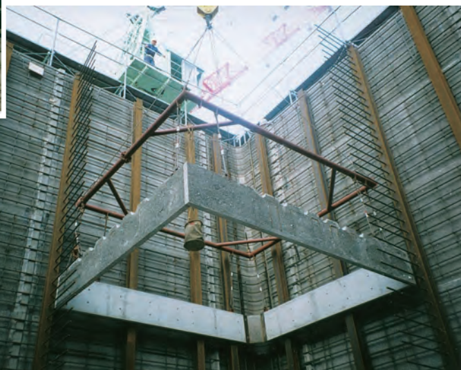
内部隔壁 RC 板の建込状況
