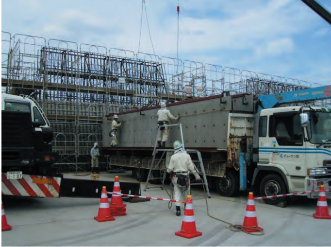
大組パネル建込状況（陸側）
