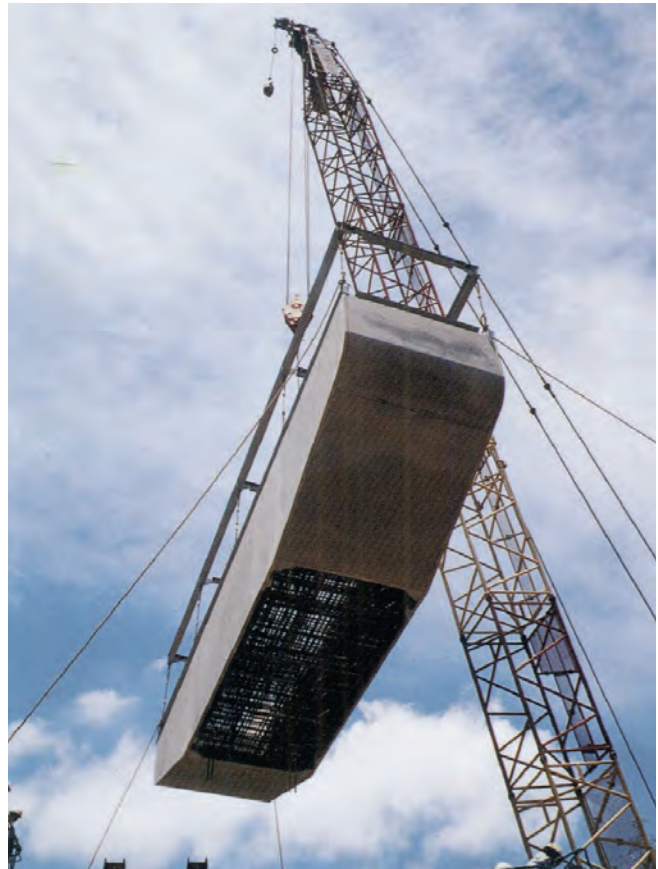
梁函体建込状況
