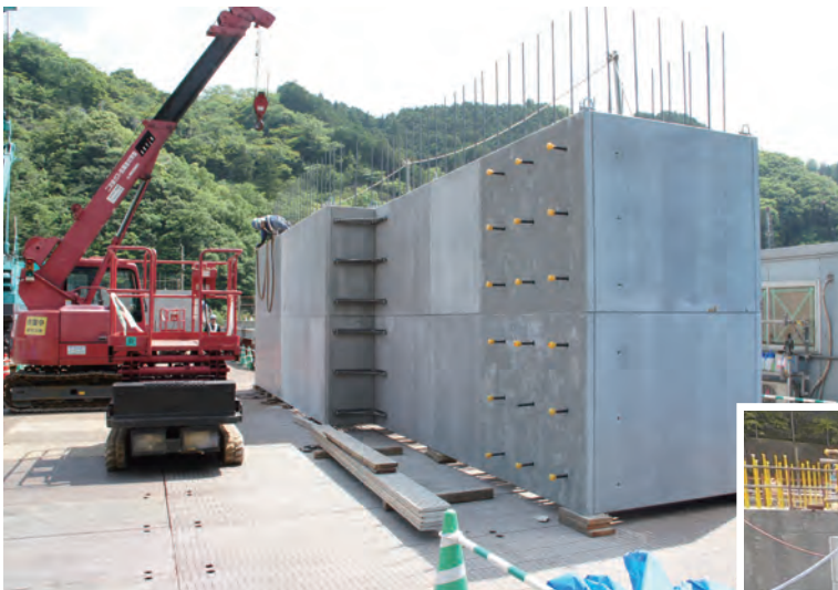
ジベル筋取付状況
