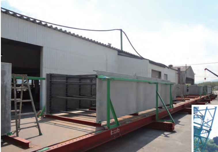
工場での函体組立状況
