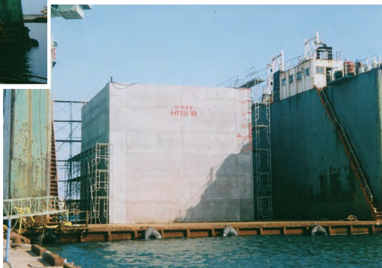
ケーソン函体の完成状況
