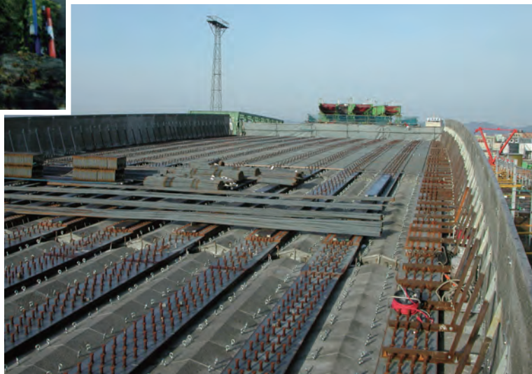
合成主桁間底版型枠設置状況
