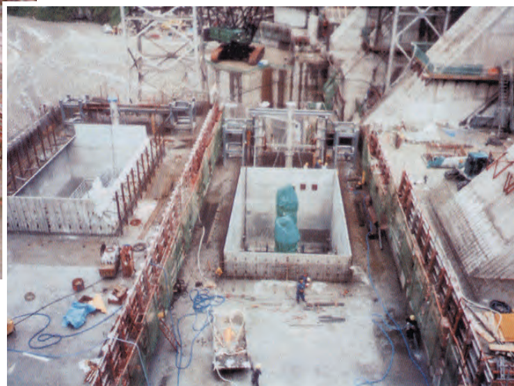
ゲート操作室側壁部 SEED フォーム
