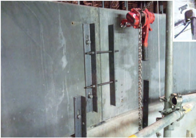
鉛直目地の仮締め状況
