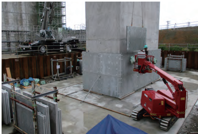
鞘管内型枠 SEED フォーム設置状況
