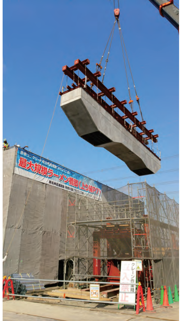
梁函体建込状況
