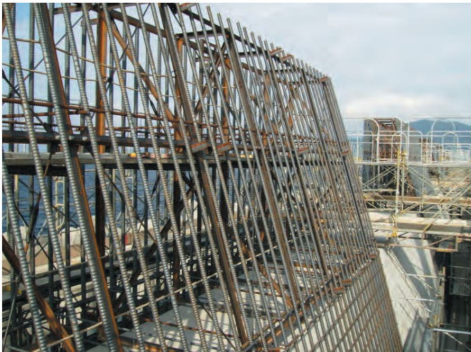
嵩上げ部の鉄筋配置（陸側）
