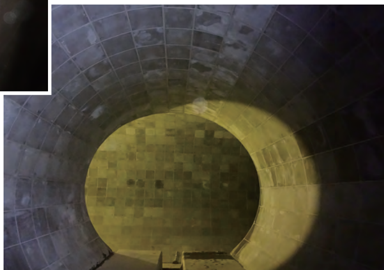
支管から見た合流部
