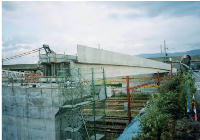
張出し部底型枠・高欄外面型枠設置状況
