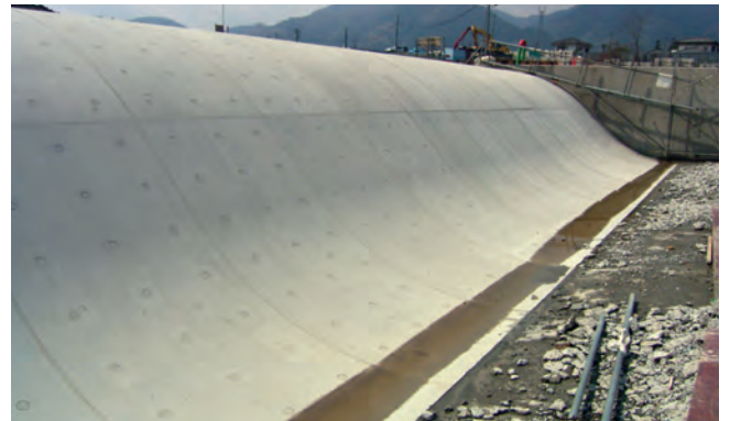
下流側設置状況
