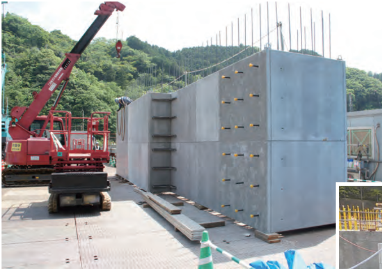
ジベル筋取付状況
