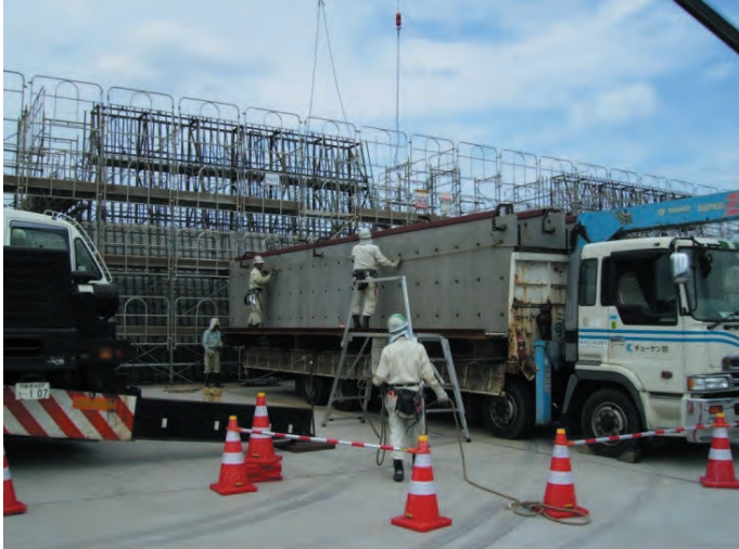
大組パネル建込状況（陸側）
