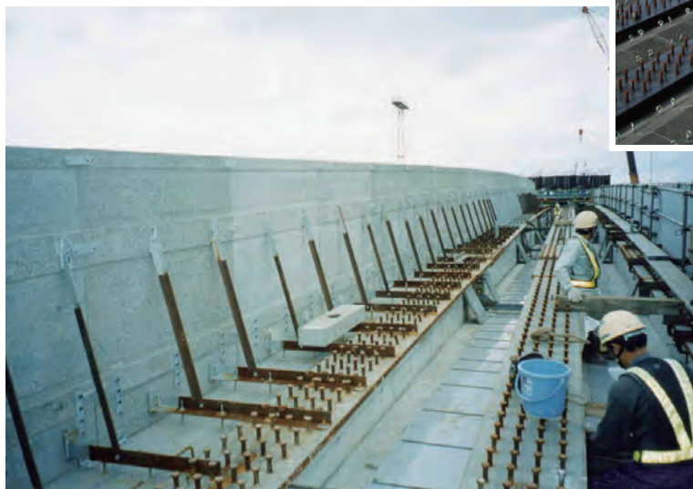
高欄型枠内面固定状況
