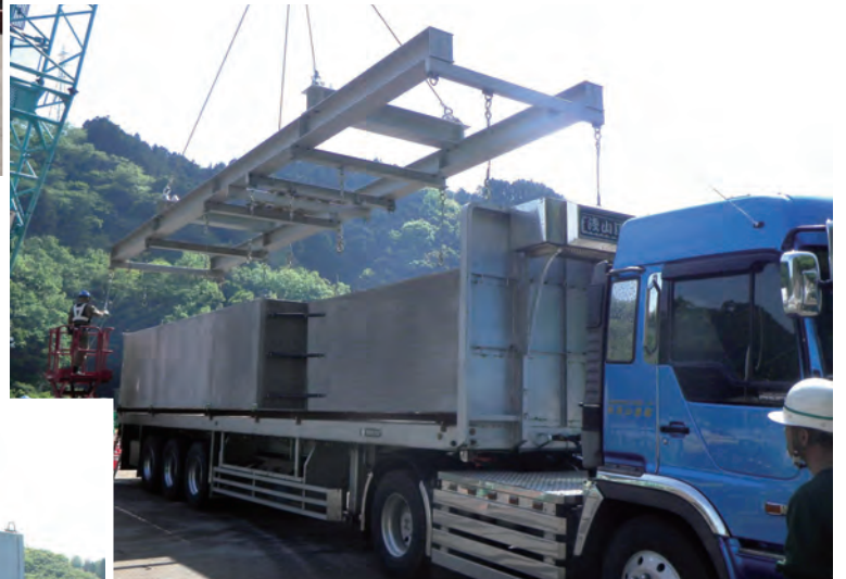
函体現場搬入状況
