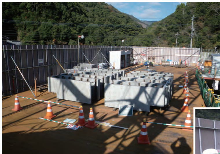
函体組立後の仮置状況
