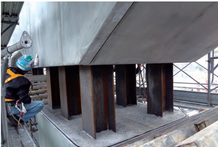
梁函体設置状況
