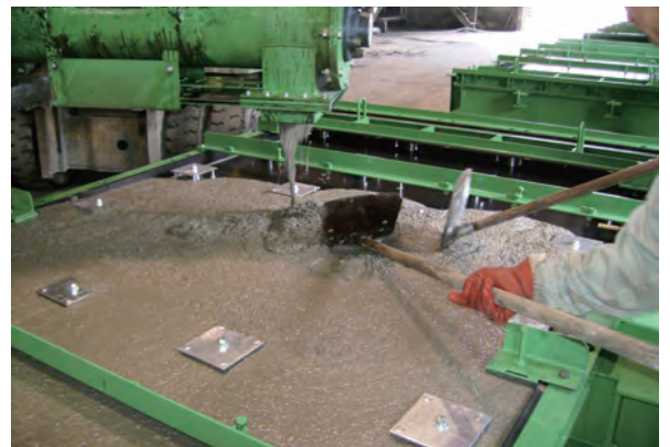
コンクリートの打設
