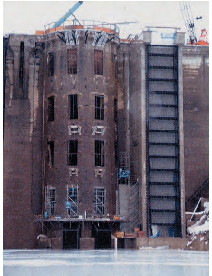
新設取水設備施工完了
