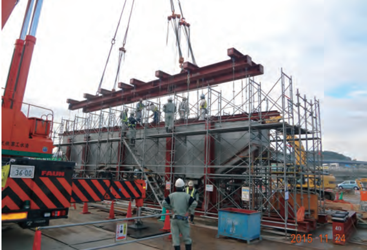
組立架台からの吊上げ状況
