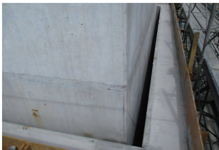
鞘管躯体コンクリート打設完了
