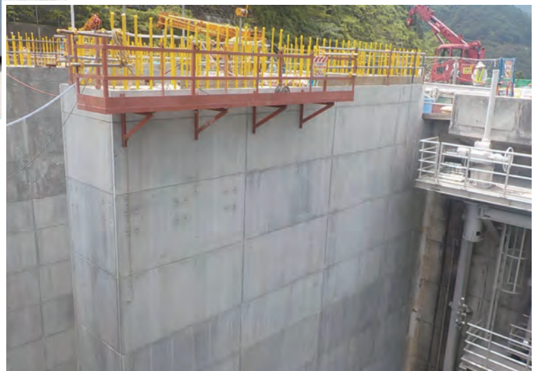
函体設置完了
