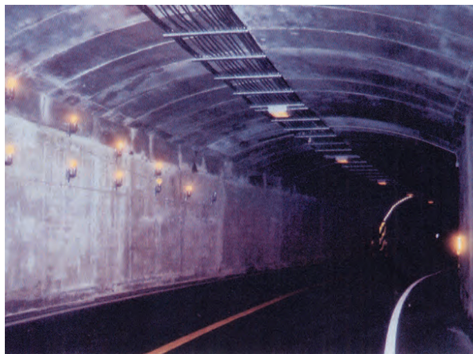
トンネルアーチ部補修事例
