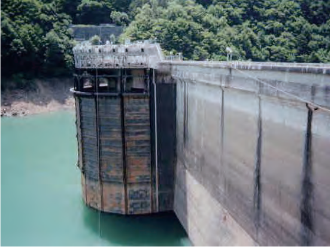
改修前の取水設備
